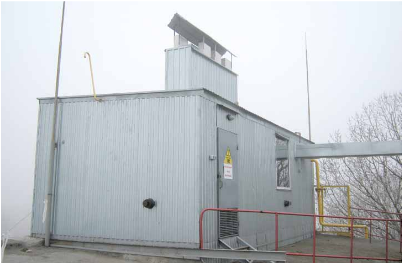
Зовнішній вигляд котельні ТОВ Санаторій Нива
