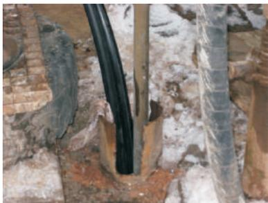
По окончании опуска вертикального грунтового коллектора скважина должна быть качественно зацементирована. Это могут быть специальные растворы с добавками усиливающими теплопроводность. Во избежание образования пустот, цементация должна проводиться снизу, под давлением при помощи растворонасоса, который способен создать необходимое давление в конкретном случае. (фото 8)
