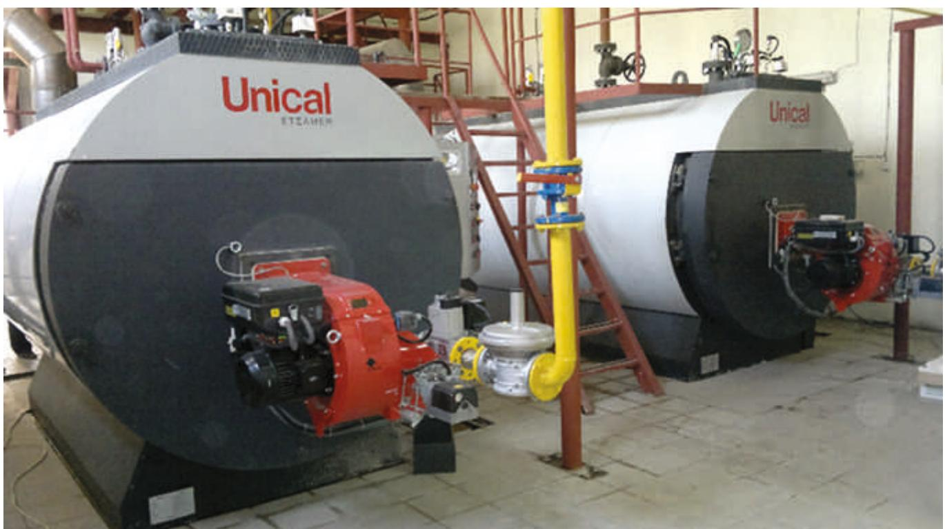
неразрушающим методом в соответствии с внутренним «Планом производства и контроля». Дымогарные трубы, составляющие трубный пучок, изготовлены из высококачественной стали и приварены к трубным доскам при помощи автоматической сварки. Затем они слегка разваликованы. Это позволяет получить качественное соединение труб с передней трубной доской и предотвратить образование известковых отложений. И, наконец, трубы заторцованны методом цековки, чтобы избежать выступа трубы за трубную доску.
